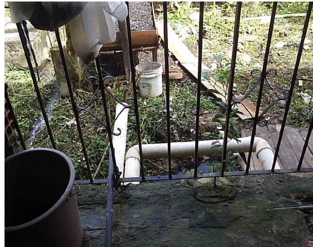
Figura 45 – Esgoto sanitário em casa do Riacho Doce. Fonte: Direta, 2007.
