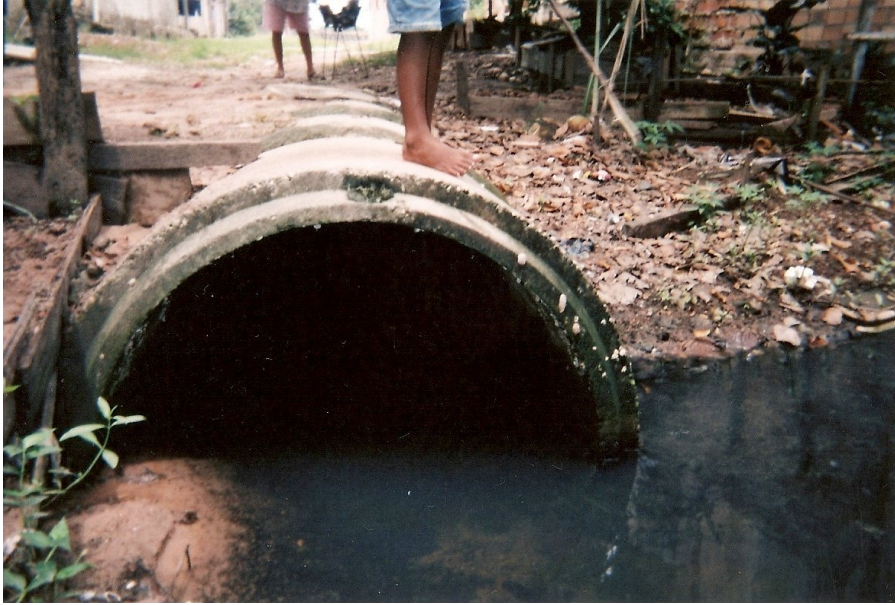
Figura 46 – Tubulação de Drenagem que lança esgoto e águas pluviais no Igarapé Tucunduba. Fonte: Direta, 2007.
